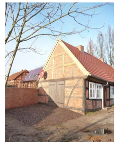
Giebel nach Fertigstellung
