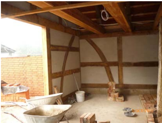
Aufbau des neuen Ziegelbodens
