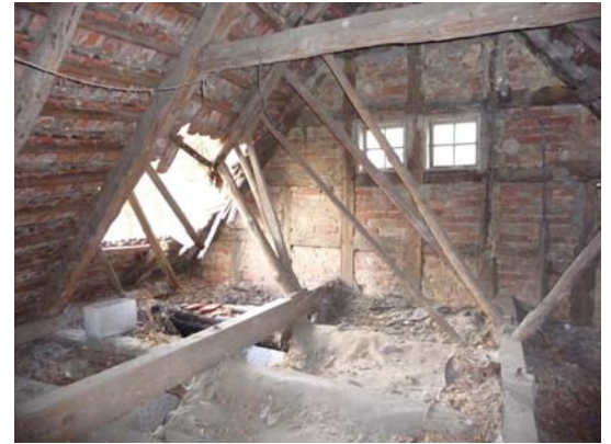
Zustand 2009 während der Notsicherung
