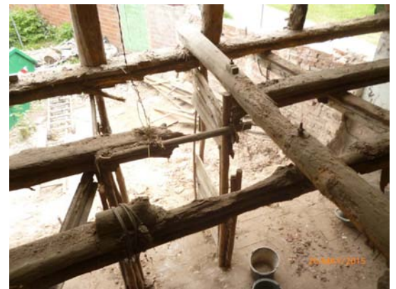
Blick ins Innere während der Sanierung
