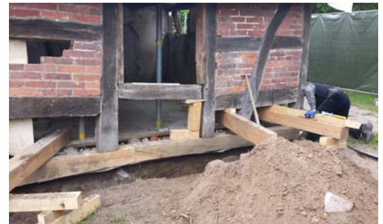
Austausch des Fußrahms und Anheben der Ecke
