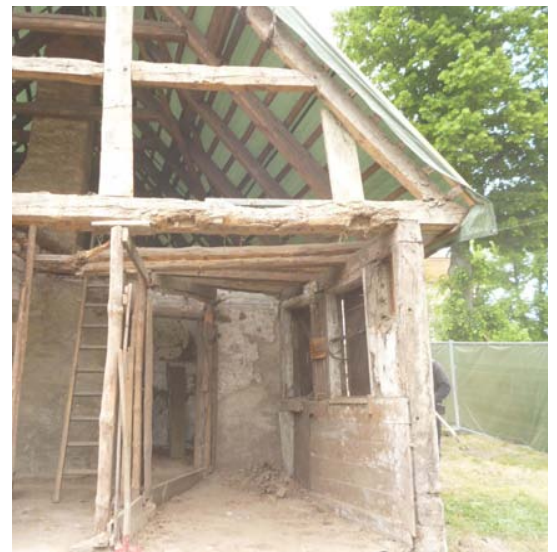
Blick ins Innere während der Sanierung
