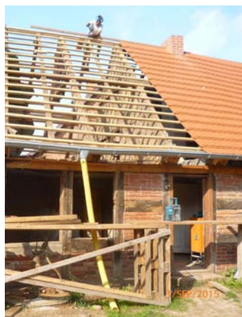
Wiederaufbau des Daches
