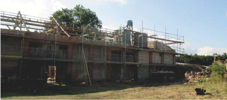
Silo Getreidespeicher mit freigelegter Dachstruktur
