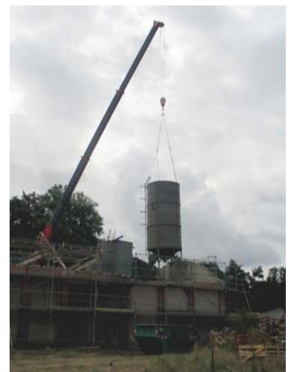
Silo Rückbau mit Kraneinsatz
