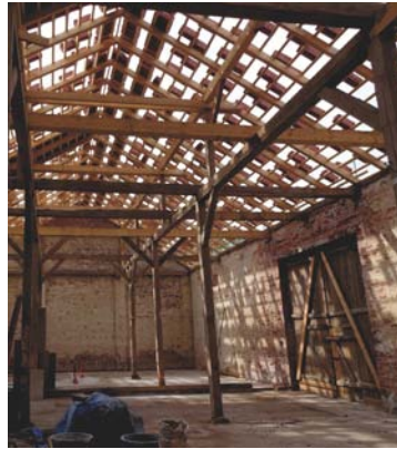
Verlegung Dachziegel
