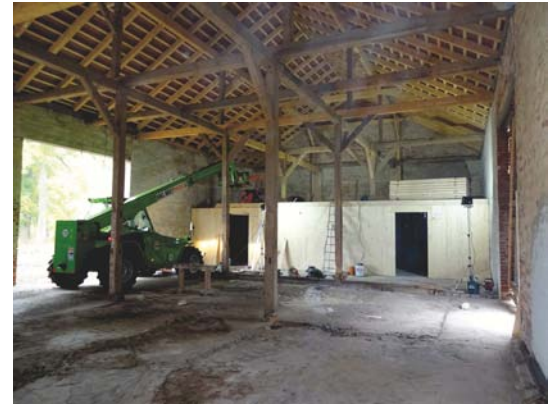
Aufbau Holzkubus aus CLT-Platten
