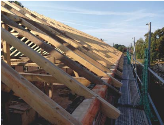
Dachstuhl mit Verwendung der restlichen Bestandssparren
