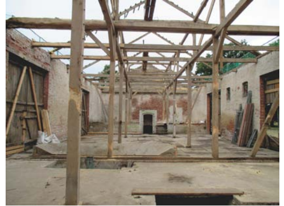
Scheune Innen entkernt
