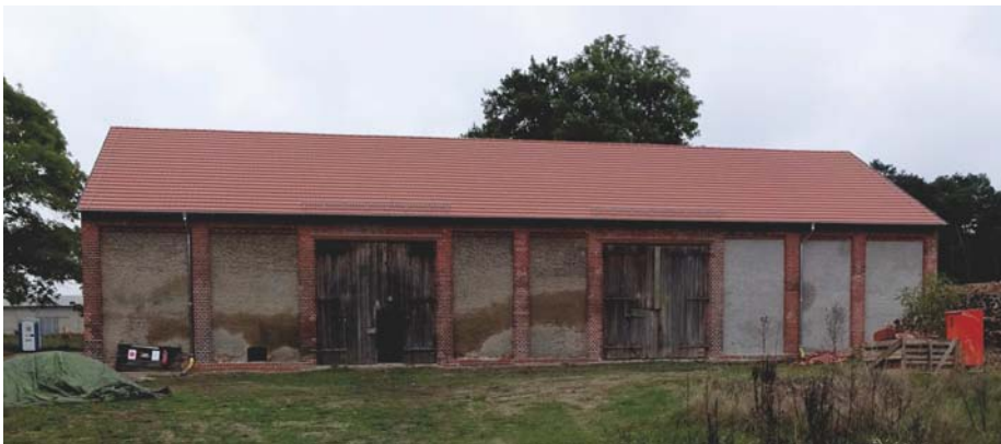
Fertigstellung Dach und verputzte bzw. ausgebesserte Wandflächen
