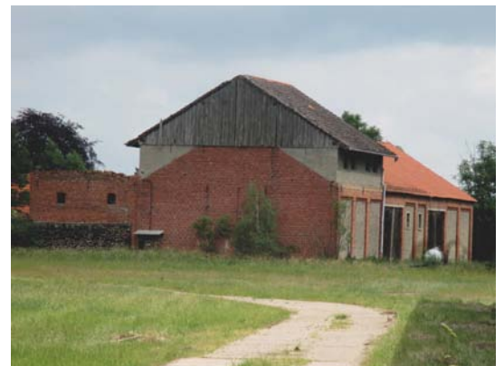
Sichtbare frühere Baustruktur - Aufstockung
