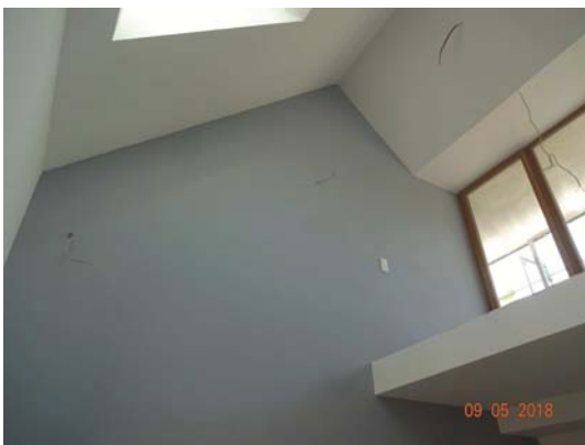
Maisonette-Zimmer Galerie noch ohne Treppe
