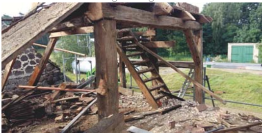
Wohnhaus Rückbau Dachgeschoss
