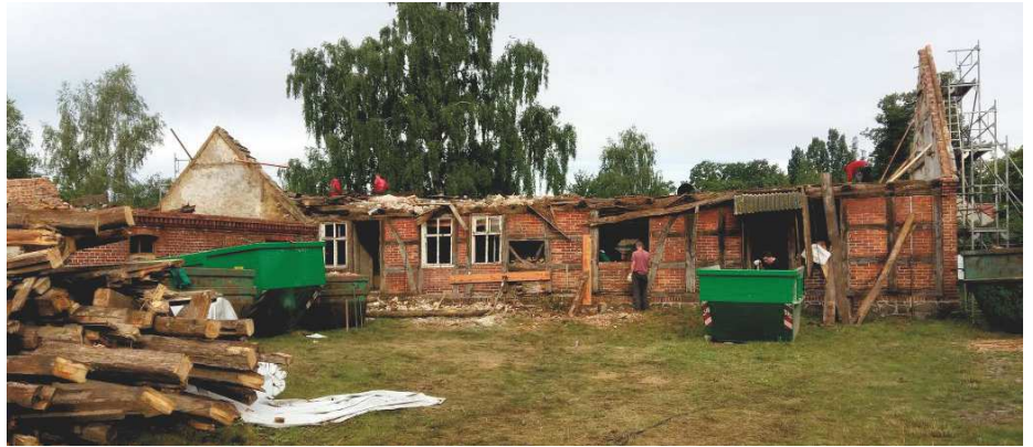
Wohnhaus + Stall rückgebaute Dächer
