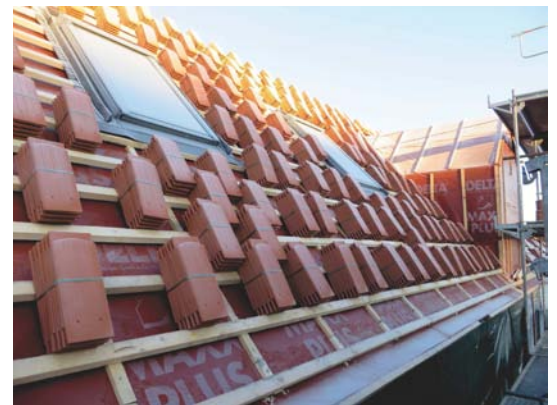
Wohnhaus Verlegung Dachziegel
