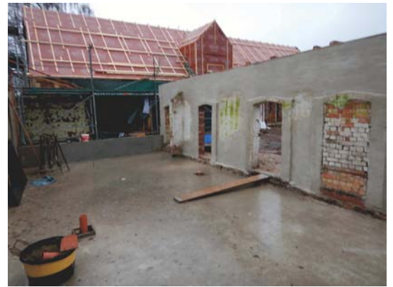
Stall entkernt mit neuer Bodenplatte
