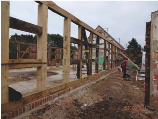
Wohnhaus Reparatur Fachwerk mit Alt+Neusubstanz
