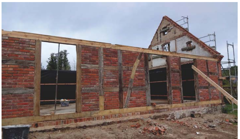
Wohnhaus: wieder aufgebaute Hoffassade
