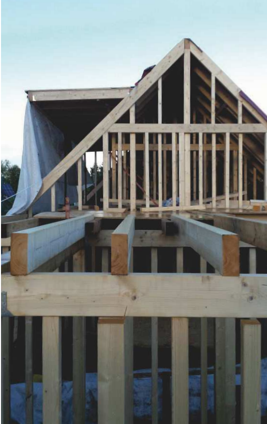
Wohnhaus neue Holzständerwand
