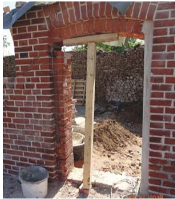
Stall Sicherung Türsturz
