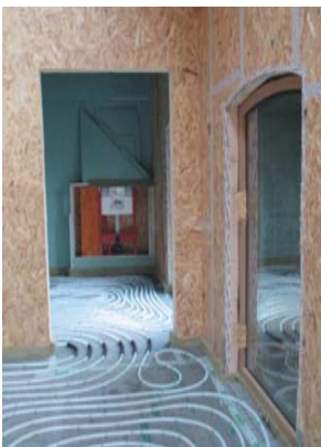
Fußbodenheizung
