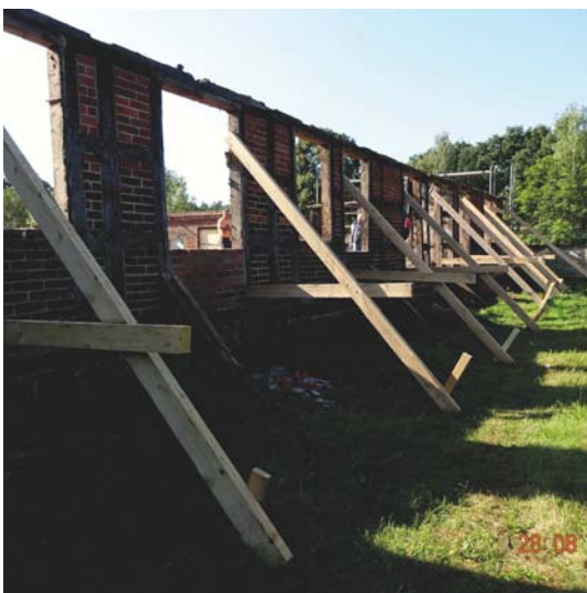
Wohnhaus Bestandsfachwerk gestützt
