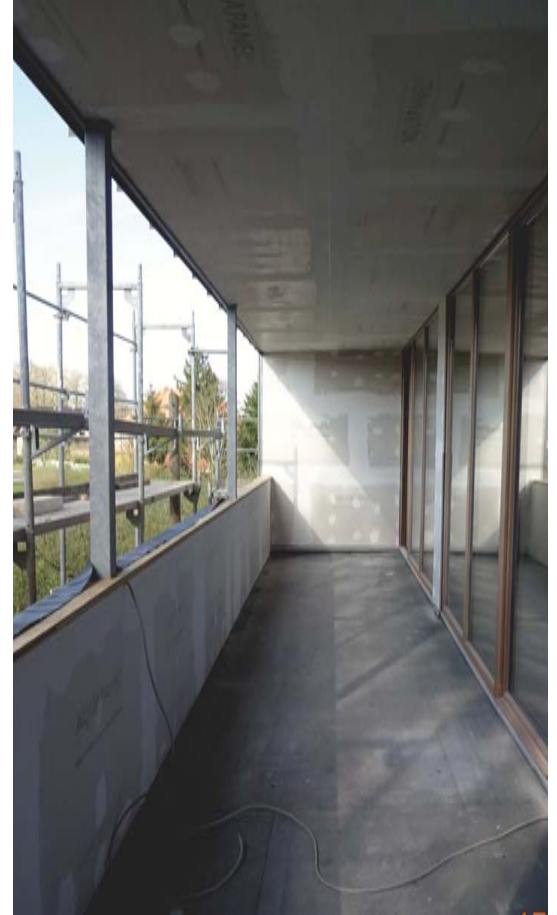
Wohnhaus Balkon noch ohne Trennwände
