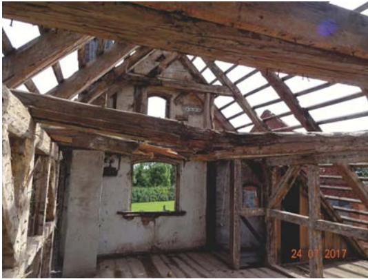
Wohnhaus Entkernung Dachgeschoss
