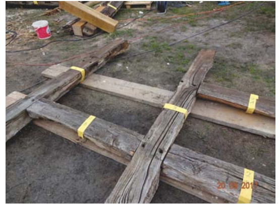
Fachwerk Vorbereitung zum Wiederaufbau
