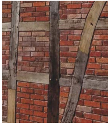
neu ausgemauerte Gefache mit alten Ziegeln
