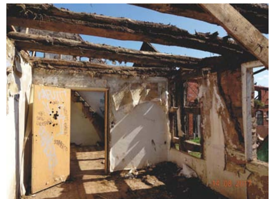
Wohnhaus Entkernung Erdgeschoss
