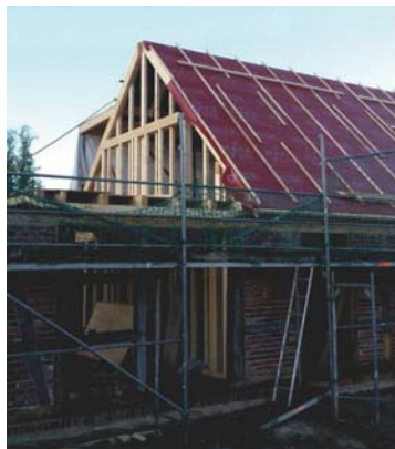
Wohnhaus Bestand / Ständerwerk
