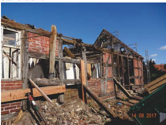
Wohnhaus Sicherung Fassade
